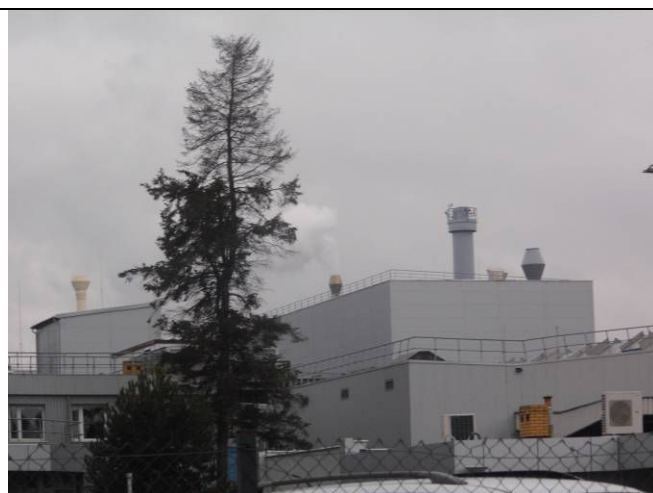
FOT 10. Obszar planu – emitory na dachu zakładu
