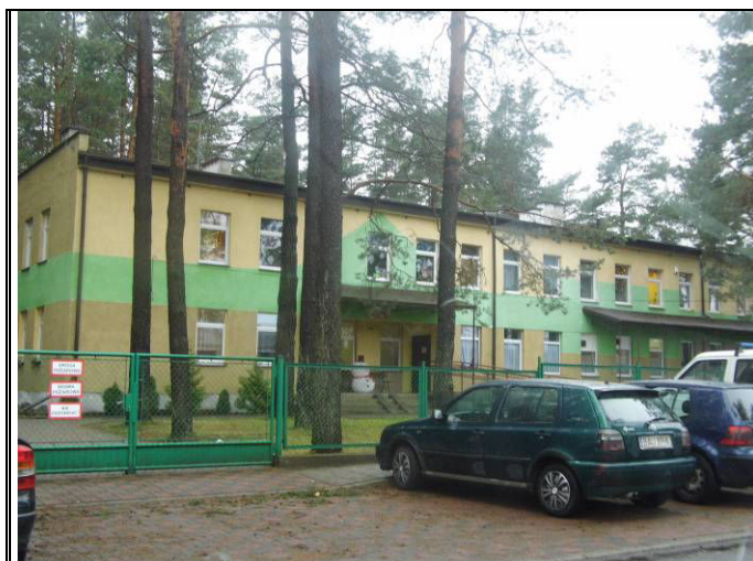
FOT 15. Obszar ościennie - budynek przedszkola
