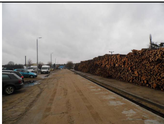
FOT 2. Strona północna – rampa kolejowa i tereny składowe
