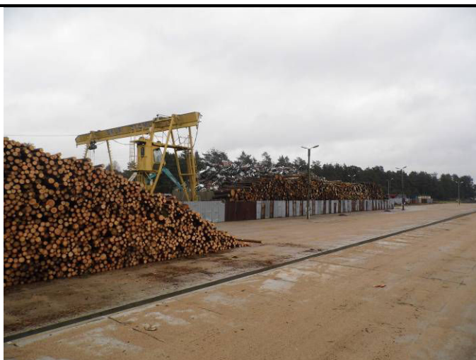
FOT 1. Strona północna – rampa kolejowa i tereny składowe
