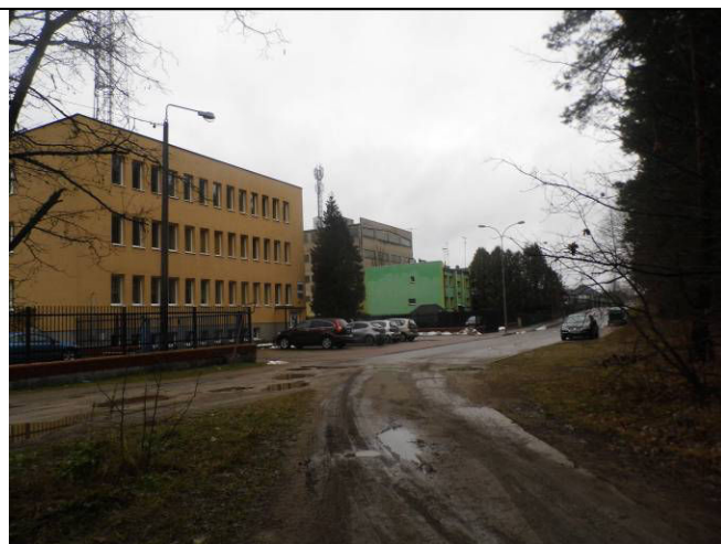
FOT 14. Obszary ościenne od strony zachodniej – zabudowa usługowo – składowo- przemysłowa.
