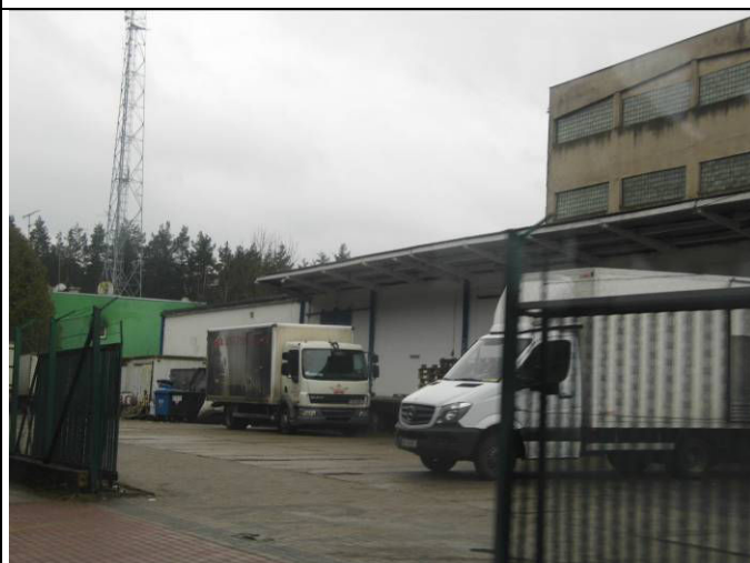
FOT 13. Obszary ościenne od strony zachodniej – zabudowa usługowo – składowo- przemysłowa.
