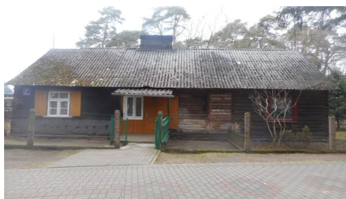
e) ul. Zarzecze 2A – 2 lokale mieszkalne (rozbiórka/sprzedaż),
