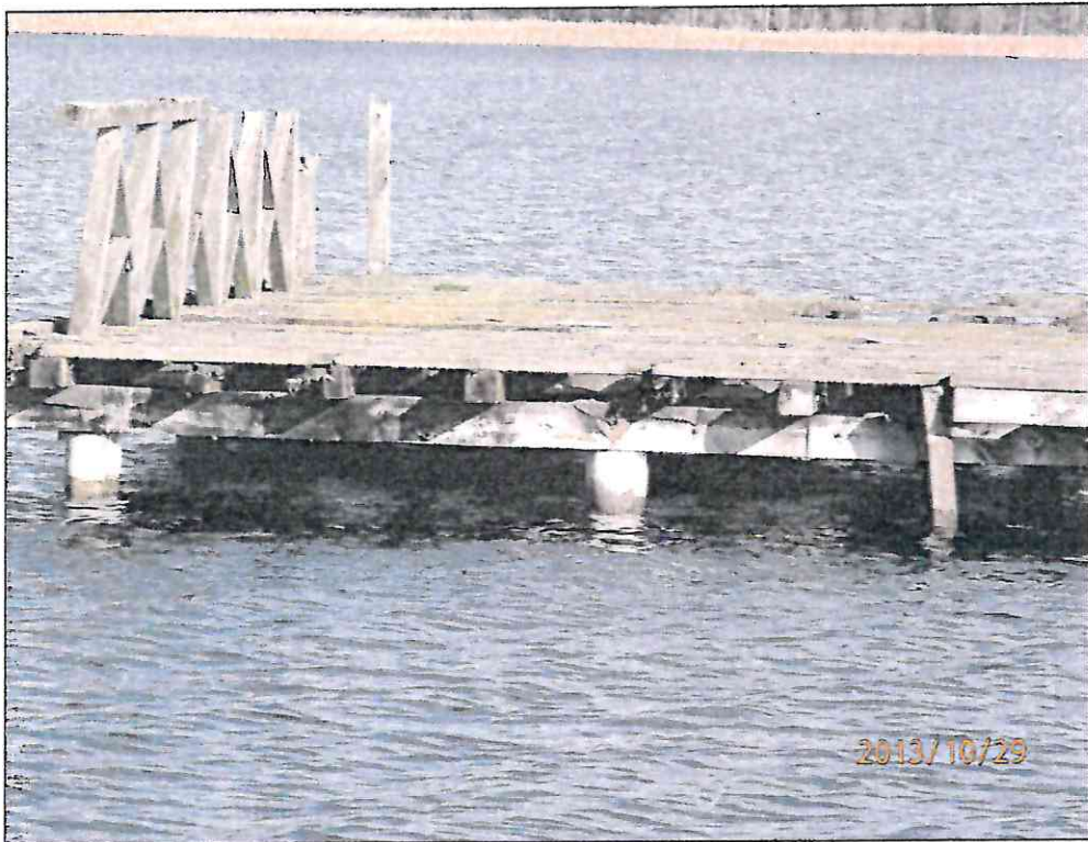
Fot.11 Uszkodzenia dźwigarów 14x14cm
