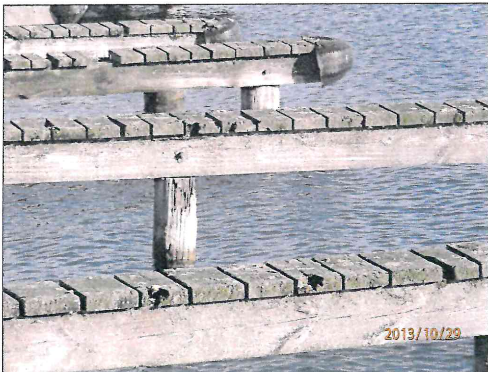
Fot.11 Uszkodzenia dźwigarów 14x14cm
