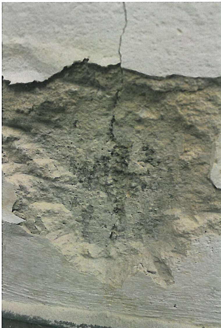
Fot. 16. Odkrywka w miejscu rysy dylatacyjnej
