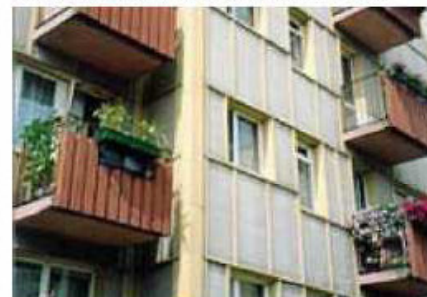
Budynek pokryty elewacją wykonaną z płyt azbestowo - cementowych płaskich
