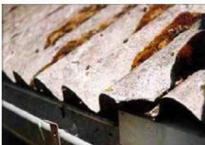
Pokrycie z płyt falistych azbestowo - cementowych
