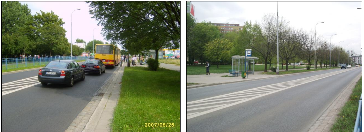
Rys. III.10. Bezpieczeństwo transportu publicznego – bezpieczny przystanek z separatorem, wykorzystujący istniejący przekrój ulicy – przykład realizacji
