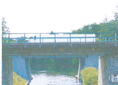
Most kolejowy i drogowy nad Klonownicą.
