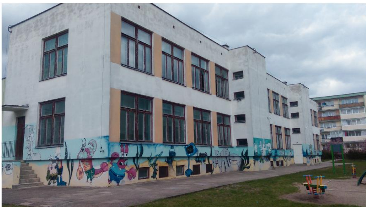
Szkoła Podstawowa nr 3 - elewacja od strony SE
